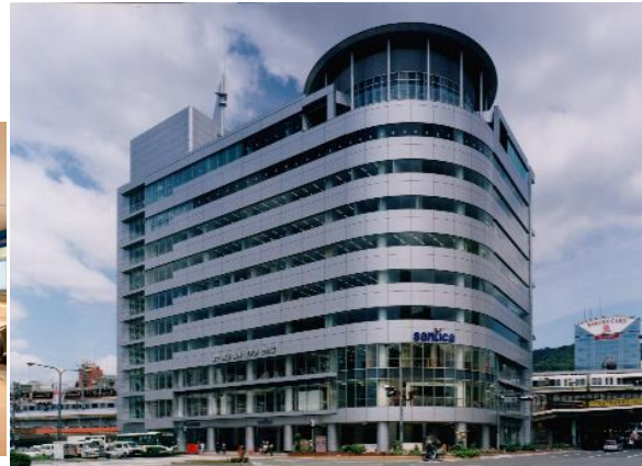
全景 1997年7月竣工
